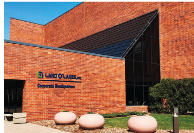
Abb. 65: Bürogebäude, Nachrüstung und Energieeinsparung von 15%.
