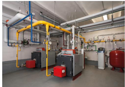
Abb. 120: Gasbrennwertkessel
